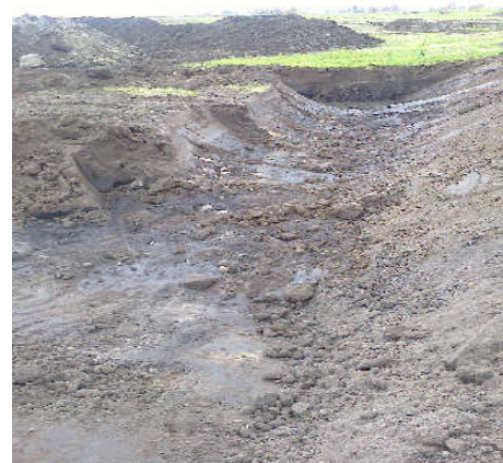
4.5 pav. Kairėje - taip atrodė drenažo žiotys sedimentacijos tvenkinėlio Tv1 įrengimo vietoje 2015-01; dešinėje – pradėti tvenkinėlio statybos darbai, atkastas drenažo rinktuvus 2015-10
