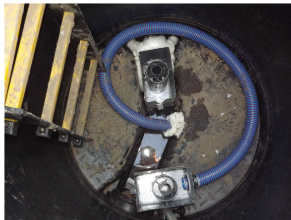
4.14 pav. Vandens ištekėjimo lygio pakėlimo vamzdis šulinyje (kairėje), drenažo šulinys su nuotėkio matavimo įranga (dešinėje)
