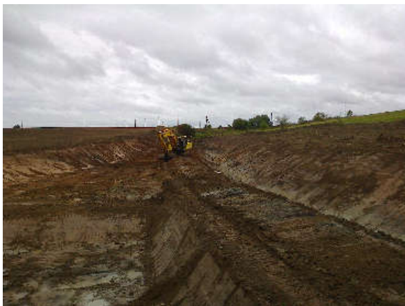
4.10 pav. Kairėje – sedimentacijos tvenkinėlio Tv 3 įrengimo dabai (apsauginio pylimo statyba) 2015-09; dešinėje - suformuotas tvenkinėlio dugnas, pasodinti augalai 2015-10
