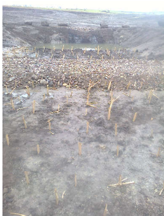
4.6 pav. Kairėje – suformuotas sedimentacijos tvenkinėlis (Tv1), įrengta akmenų užtūra, sekliosiose dalyse pasodinti augalai 2015-10; dešinėje – tvenkinėlis 2016-01, matosi paviršinio vandens prietaka polaidžio metu
