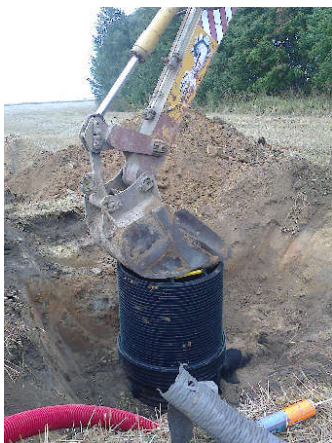
4.13 pav. Drenažo nuotėkio reguliavimo šulinių statybos darbai 2015-09
