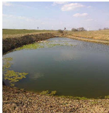
4.12 pav. Kairėje – paviršinė prietaka į tvenkinėlį 2016-02 (projektinis vandens lygis buvo pasiektas 2016-02); dešinėje – tvenkinėlyje veši siūliniai dumbliai (sodintų augalų vegetacija dar neprasisidėjusi) 2016-03
