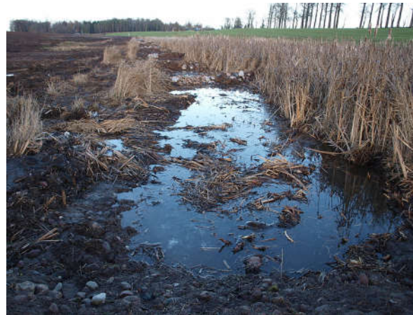
4.2 pav. Praplatinta ir pagilinta griovio vaga, suformuota gilioji dalis (kairėje), šlapynės sekliojoje dalyje griovio vaga pertverta akmenų užtvaramis (dešinėje)
