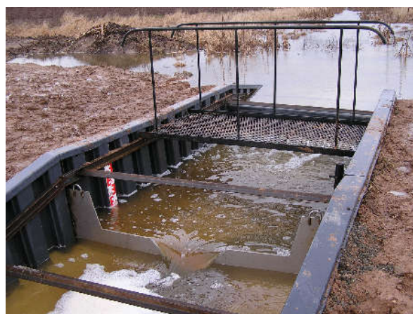
4.3 pav. Įrengtas pritekančio į šlapynę vandens monitoringo postas su kombinuoto profilio nuopyla (kairėje), įrengtas ištekančio vandens monitoringo postas (dešinėje)
