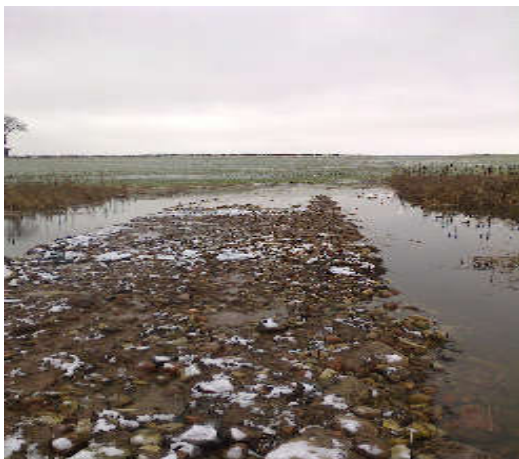
5.3 pav. Kairėje - šlapynės persilieėjimo dalis per 2016 m. pavasario polaidį (akmenų užtūra nepakankamai išlyginta, vanduo teka palei vieną kraštą); dešinėje – vandeniui nusekus akmenų užtūros paviršius išlygintas
