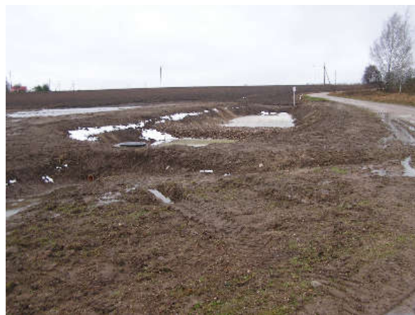
4.8 pav. Dešinėje – sedimentacijos tvenkinėlio Tv2 įrengimo darbai 2015-108 (priekyje iškasta gilioji dalis); įrengtas tvenkinėlis žiemos metu stovėjo neužsipildęs vandeniu 2016-01
