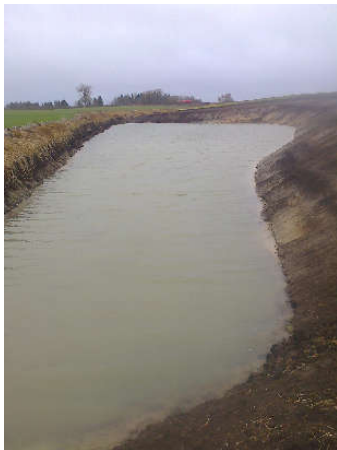
4.2 pav. Praplatinta ir pagilinta griovio vaga, suformuota gilioji dalis (kairėje), šlapynės sekliojoje dalyje griovio vaga pertverta akmenų užtvaramis (dešinėje)
