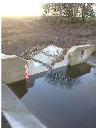
4.3 pav. Įrengtas pritekančio į šlapynę vandens monitoringo postas su kombinuoto profilio nuopyla (kairėje), įrengtas ištekančio vandens monitoringo postas (dešinėje)
