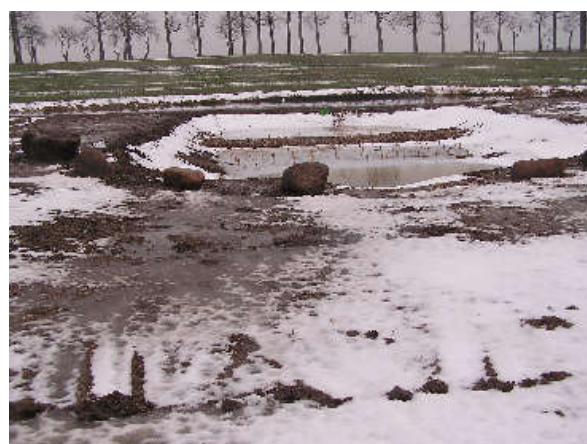
4.6 pav. Kairėje – suformuotas sedimentacijos tvenkinėlis (Tv1), įrengta akmenų užtūra, sekliosiose dalyse pasodinti augalai 2015-10; dešinėje – tvenkinėlis 2016-01, matosi paviršinio vandens prietaka polaidžio metu
