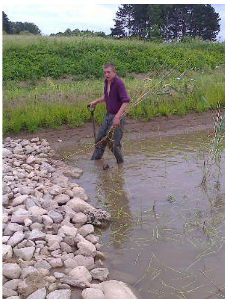
5.3 pav. Kairėje - šlapynės persilieėjimo dalis per 2016 m. pavasario polaidį (akmenų užtūra nepakankamai išlyginta, vanduo teka palei vieną kraštą); dešinėje – vandeniui nusekus akmenų užtūros paviršius išlygintas
