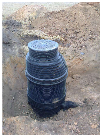
4.13 pav. Drenažo nuotėkio reguliavimo šulinių statybos darbai 2015-09
