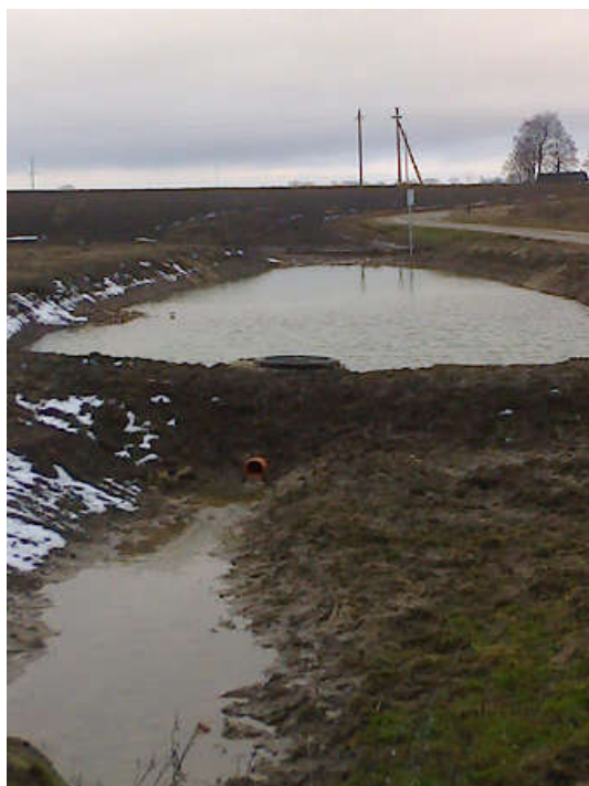
4.8 pav. Dešinėje – sedimentacijos tvenkinėlio Tv2 įrengimo darbai 2015-108 (priekyje iškasta gilioji dalis); įrengtas tvenkinėlis žiemos metu stovėjo neužsipildęs vandeniu 2016-01
