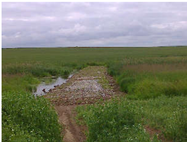
5.3 pav. Kairėje - šlapynės persilieėjimo dalis per 2016 m. pavasario polaidį (akmenų užtūra nepakankamai išlyginta, vanduo teka palei vieną kraštą); dešinėje – vandeniui nusekus akmenų užtūros paviršius išlygintas
