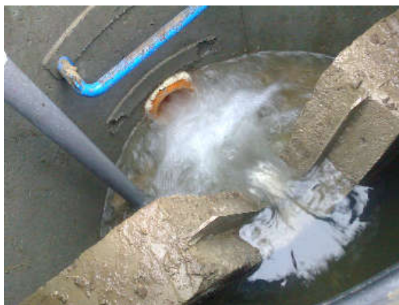
4.7 pav. Dešinėje – tvenkinėlis Tv1 užsipildęs vandeniu 2016-02 kairėje – šulinys su trikampiu nuopyla ištekancio vandens kiekiui matuoti
