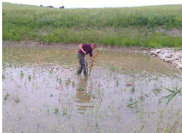
5.4 pav. Papildomas nendrių atsodinimas sedimentacijos tvenkinėlio (Tv3) sekliojoje dalyje 2016-06
