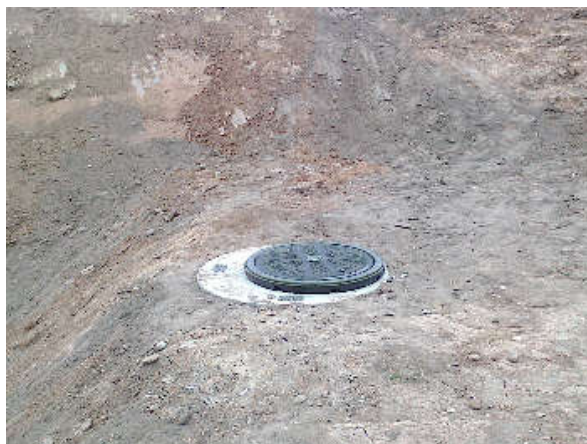
4.11 pav. Kairėje – įrengtas ištekėjimo šulinys 2015-10; dešinėje – žiemos periodu tvenkinėlis pamažu pildosi vandeniu 2016-02
