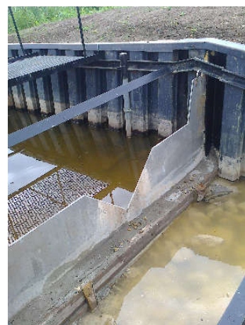
5.1 pav. Kairėje – ištekėjimo nuopylos defektų aptarimas seminario metu (2016-11); dešinėje - ištiesintas kombinuoto profilio slenkstis (2016-06)
