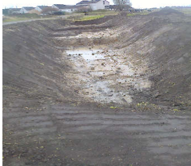
4.8 pav. Dešinėje – sedimentacijos tvenkinėlio Tv2 įrengimo darbai 2015-108 (priekyje iškasta gilioji dalis); įrengtas tvenkinėlis žiemos metu stovėjo neužsipildęs vandeniu 2016-01
